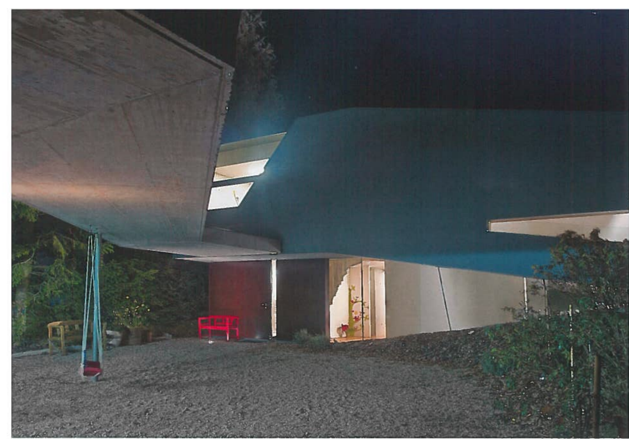
Barrierefreies Einfamilienhaus im nördlichen Waldviertel
